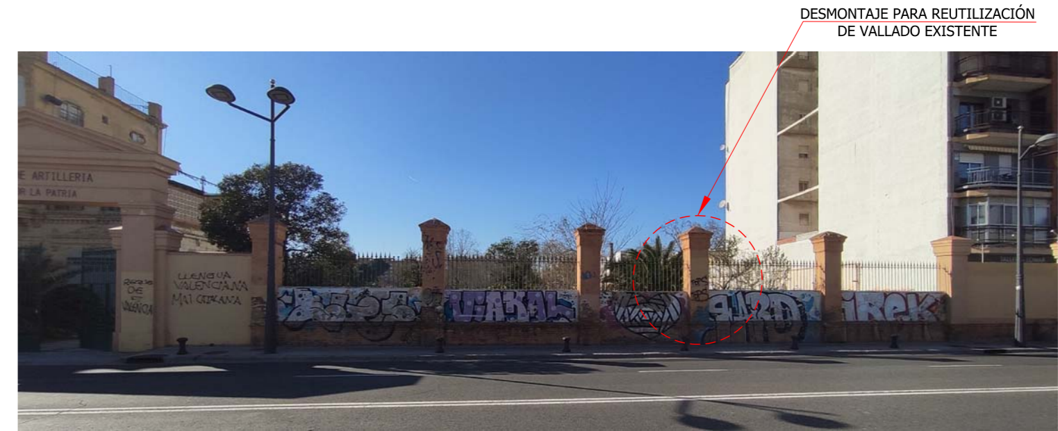
TRAMO DE VALLADO EXISTENTE A DESMONTAR S/E
