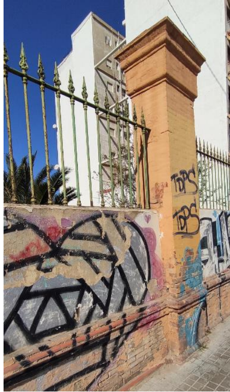
Cerramiento a calle de la Casa Feliu.
