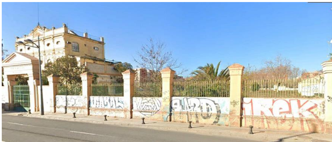
Nueva puerta y ampliación de cerramiento
