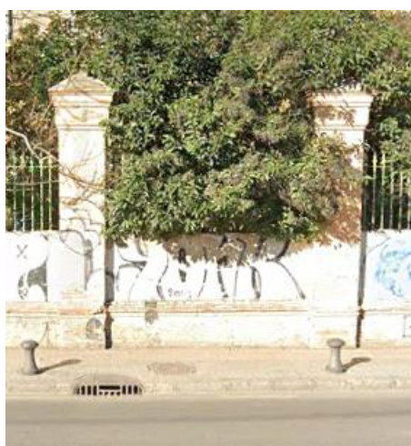
Puerta central sustituida por tramo de cierre.
