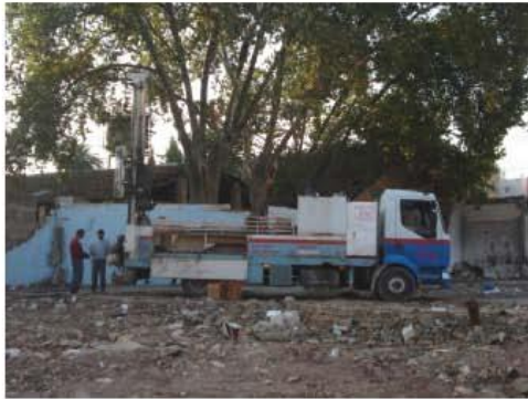
Fotografías 2 y 3: Izquierda, trabajos de emplazamiento de la máquina de penetración en el punto de investigación 5. Derecha, vista hacia el N del extremo W del Cuarte de Artillería, se marca en azul el trazado aproximado de la acequia.
