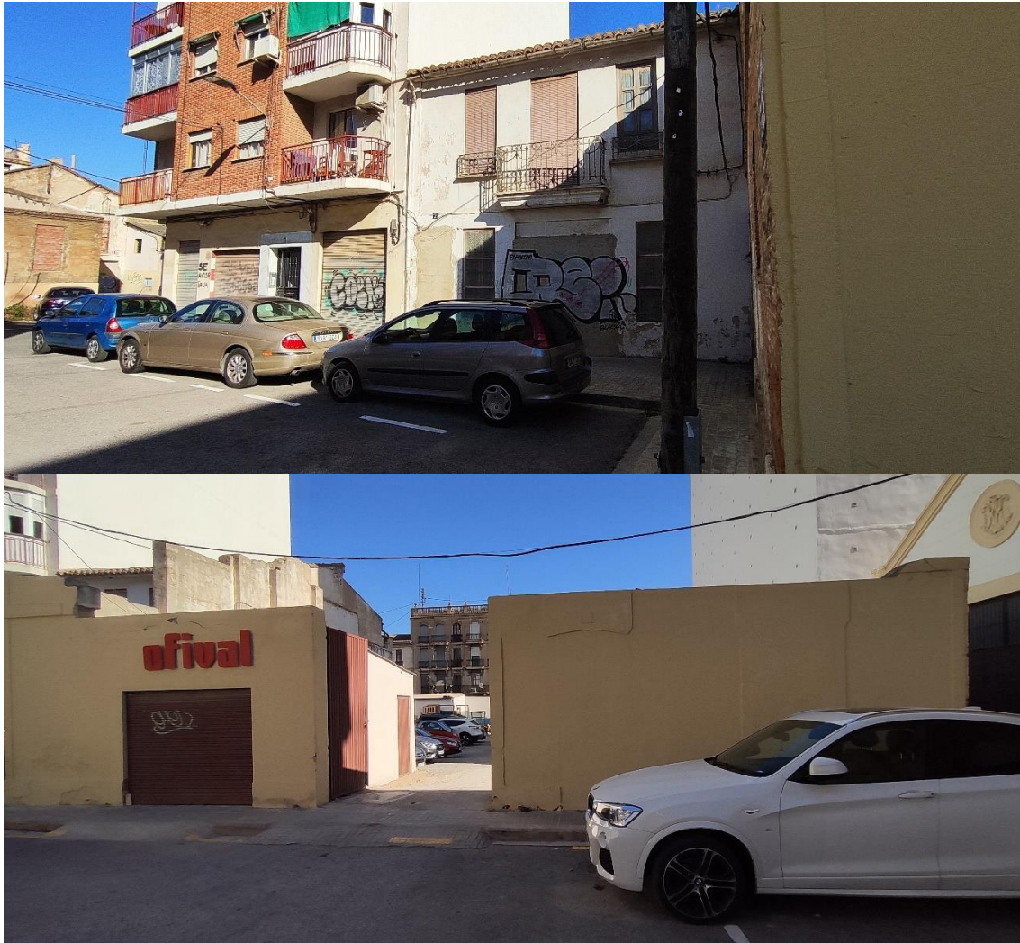
Fotos 9. Línea grapada a fachada y aérea en la Plaza Vicario Ferrer
