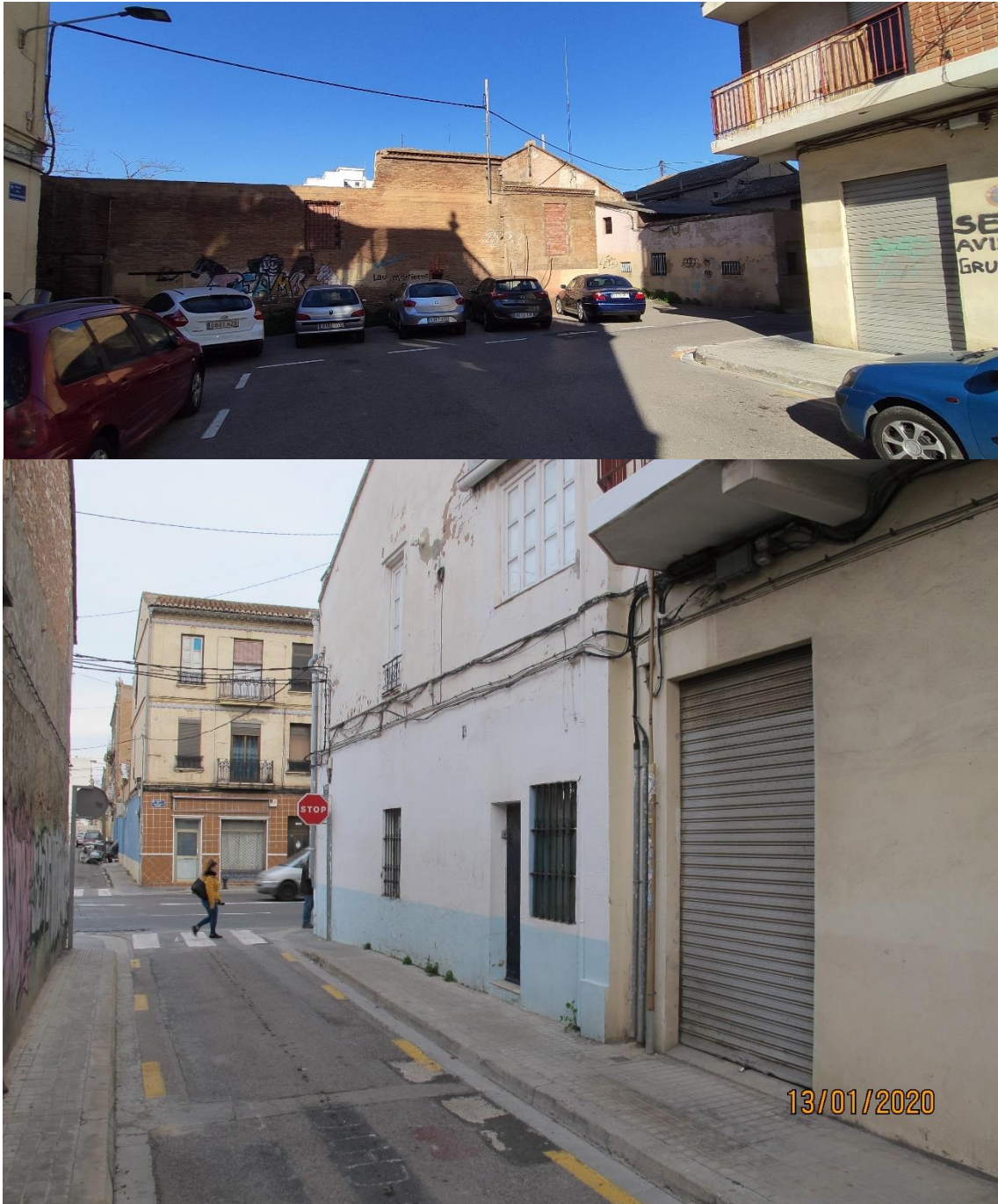
Foto 10. Línea eléctrica aérea y línea grapada a fachada en calle Mora i Xaraba
