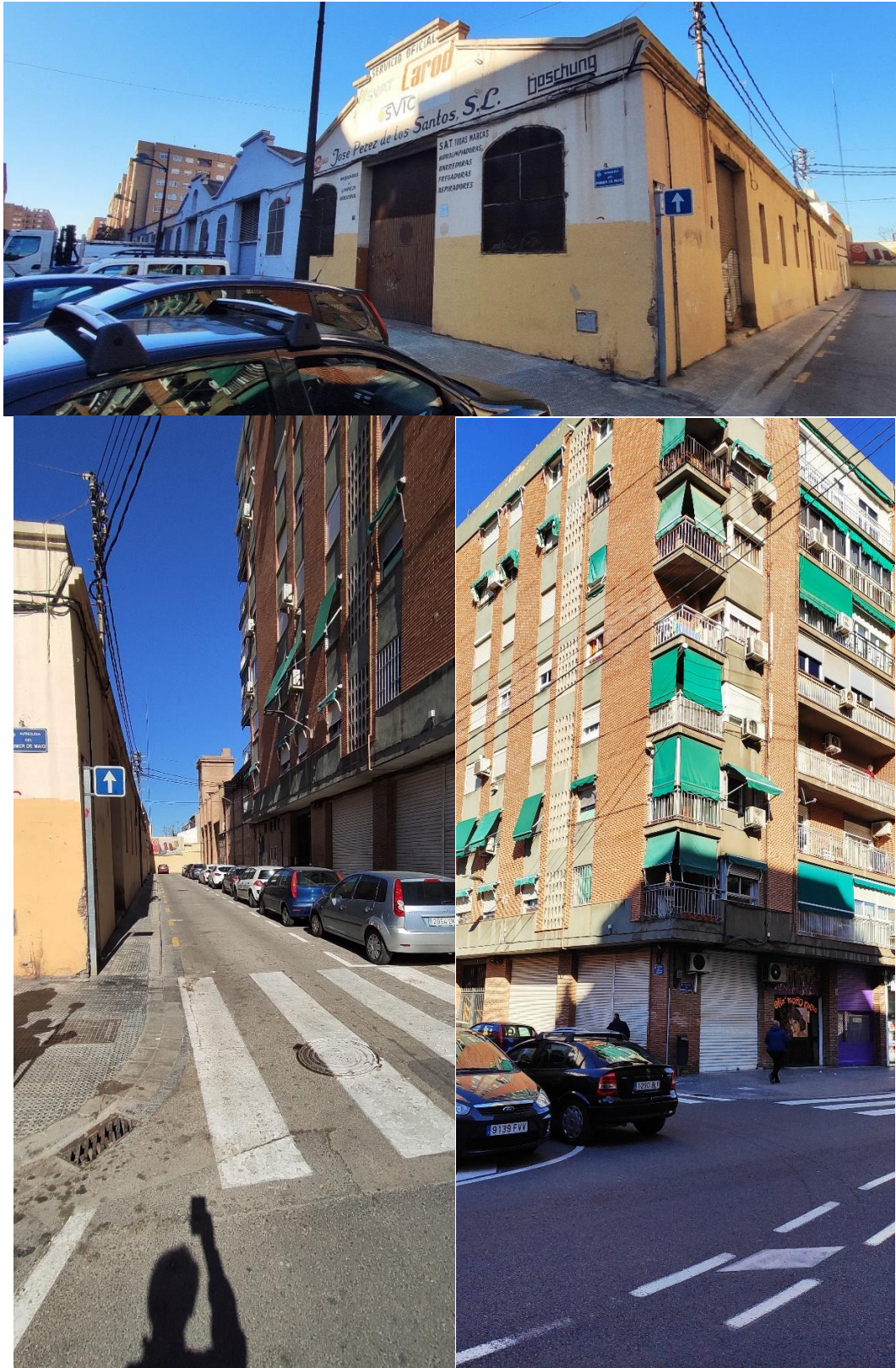
Fotos 5. Cruce de la Calle Capitular de Gandia con la Calle 1º de mayo
