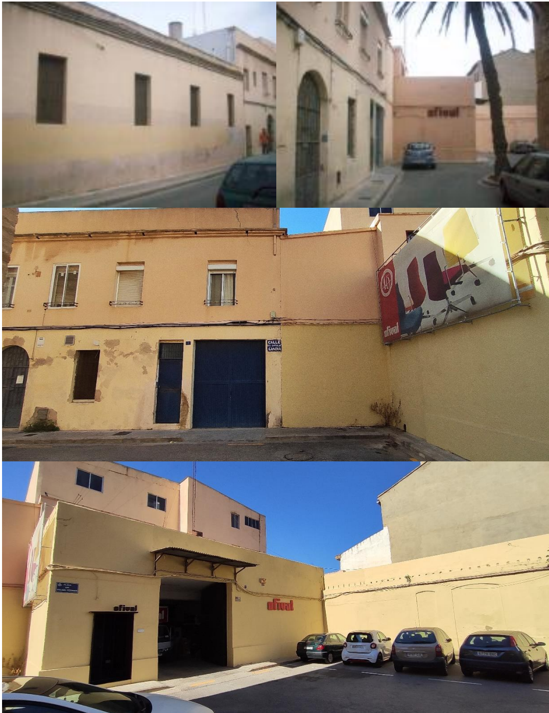
Fotos 7. Cableado por fachada en la Calla Capitular de Gandía y Plaza Vicario Ferrer
