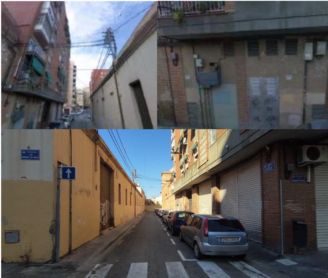
Fotos 4. Calle Capitular de Gandia con CT y montante
