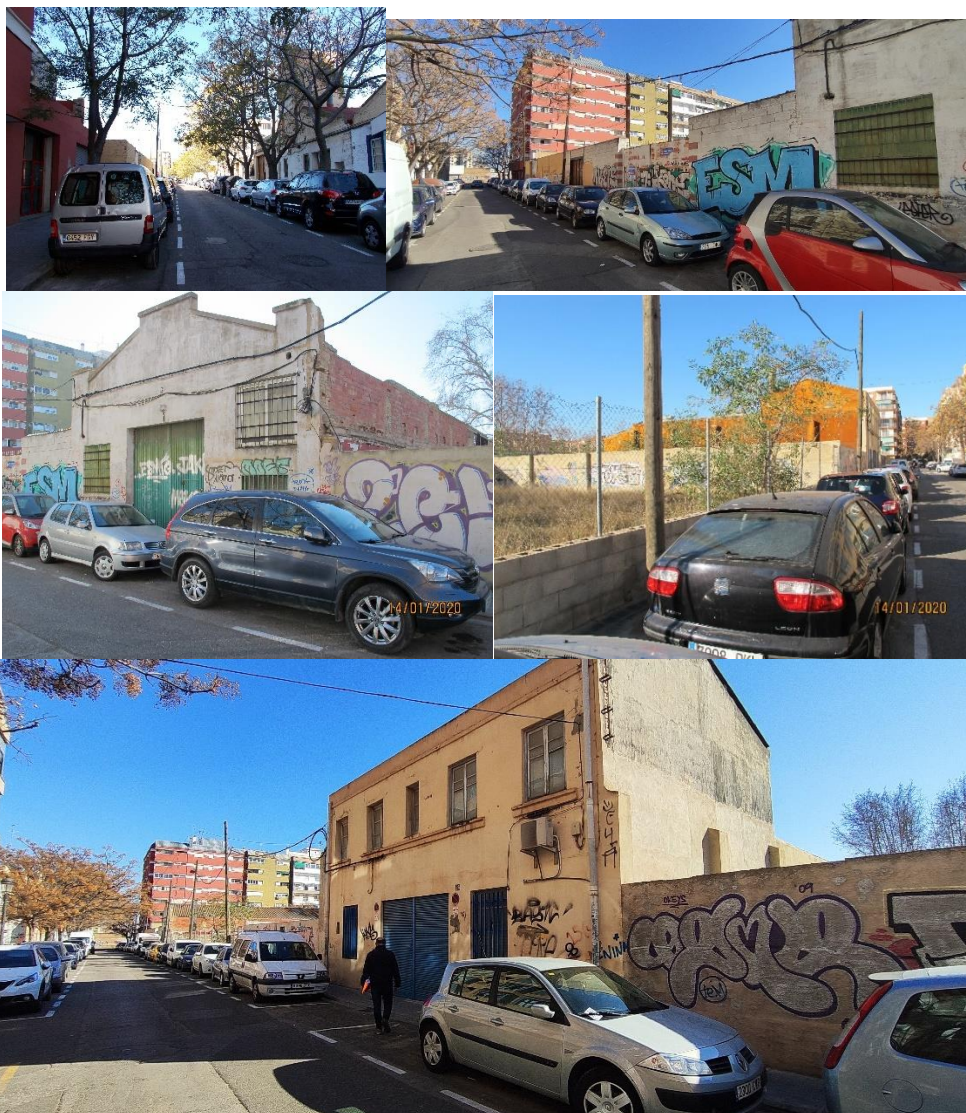
Fotos 2. Línea eléctrica aérea a eliminar en Calle Mossen Febrer
