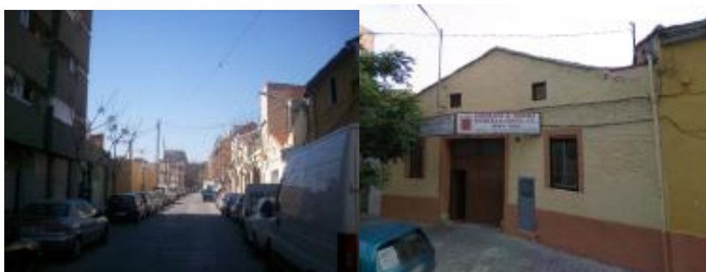
Fotos 3. Línea eléctrica aérea a mantener en cruce de la Calle Mossen Febrer
