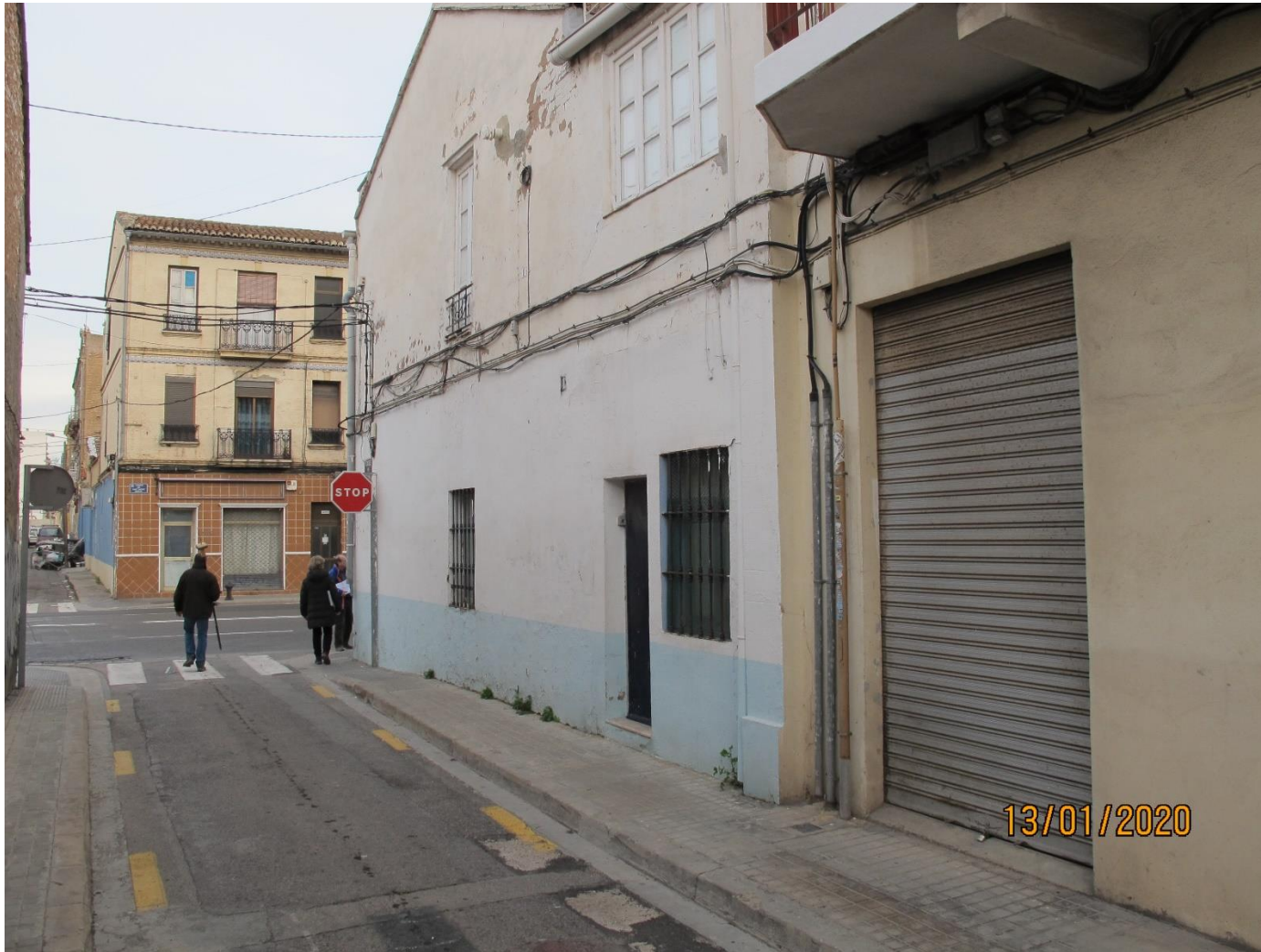
Foto 38. Fachada norte. Calle Mora y Xaraba
