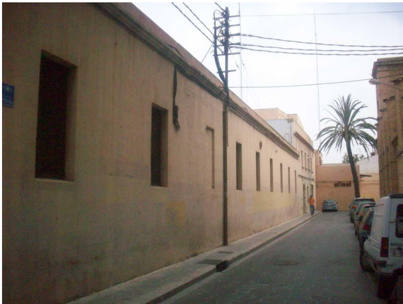
Foto 2. Fachada este. C/Capitular de Gandia.
