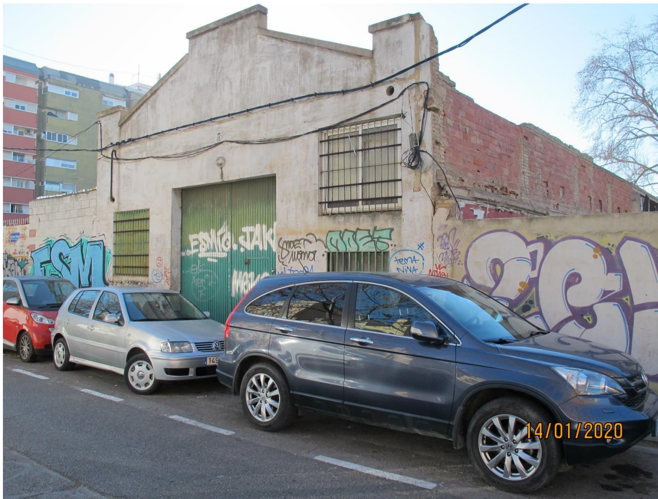
Foto 12. Fachada norte. C/Mossen Febrer
