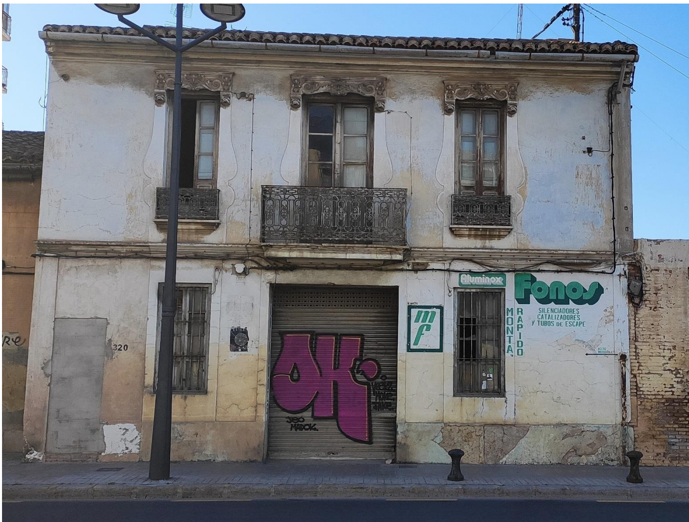
Foto 21. Fachada este. C/ San Vicente Mártir
