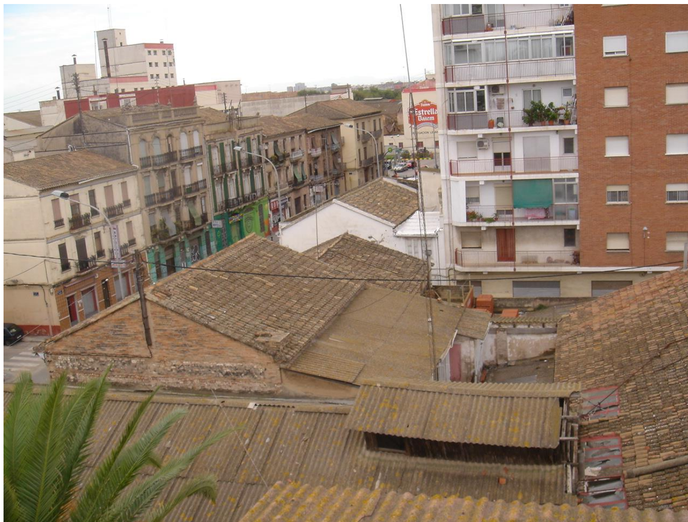
Foto 24. Fachada norte y cubierta.
