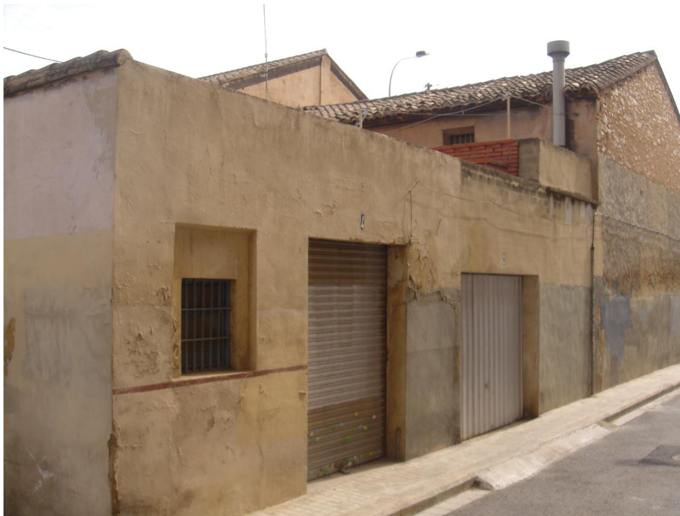
Foto 26. Fachada sur. C/ Mora i Xarabia.
