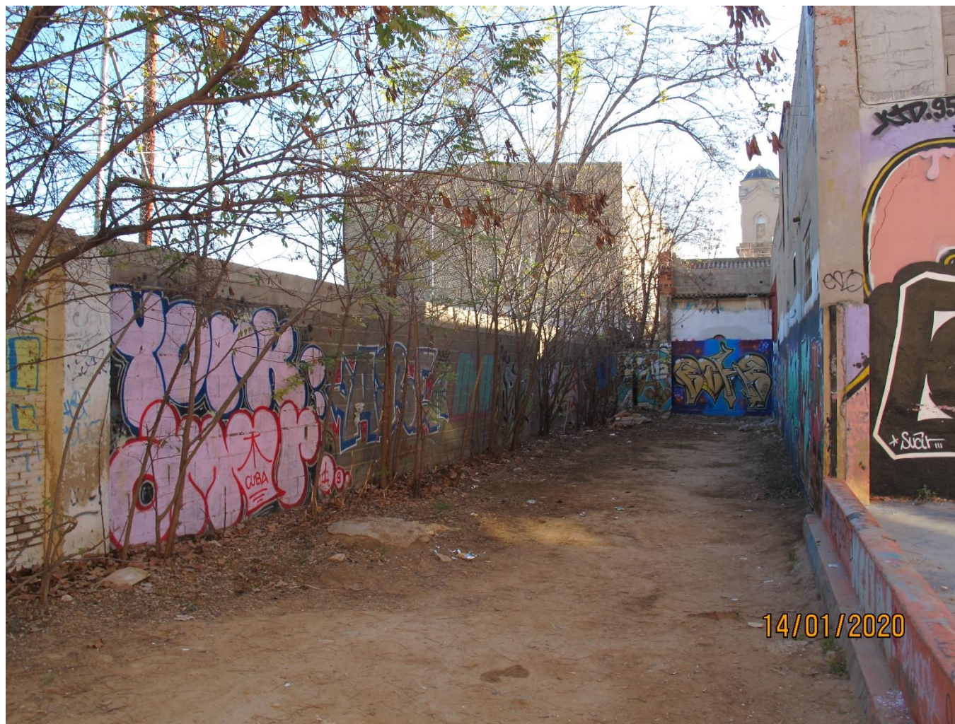
Foto 8. Fachada norte. C/Mora i Xaraba
