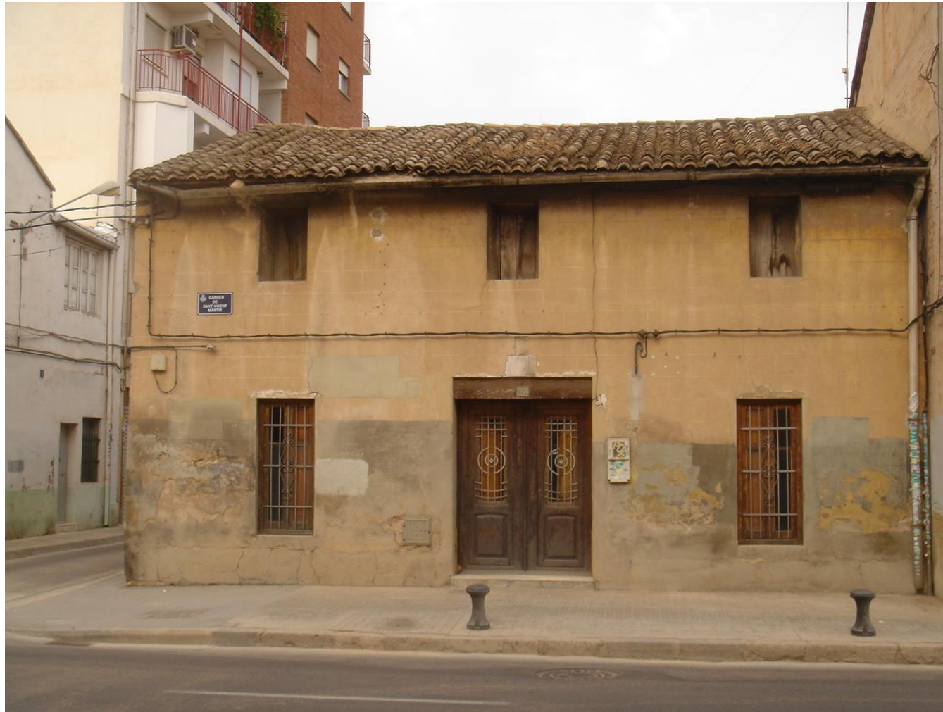
Foto 25. Fachada este. C/ San Vicente Mártir
