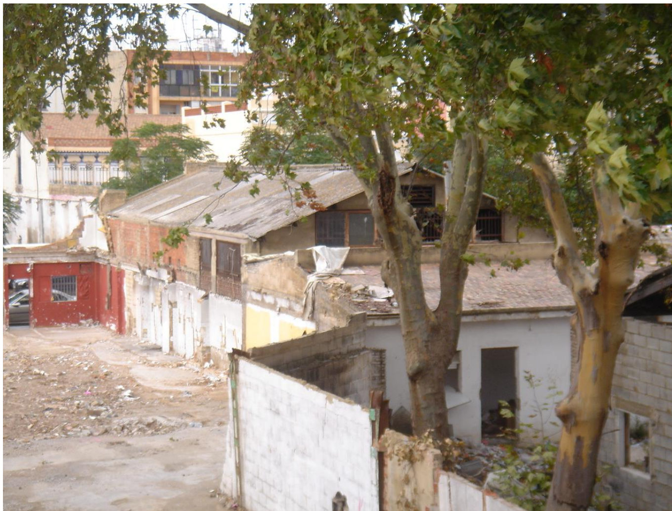
Foto 15. Fachadas oeste y sur
