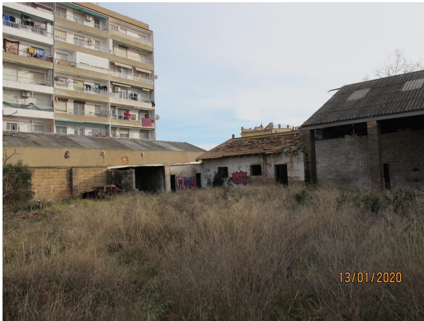
Foto 20. Fachada norte oeste
