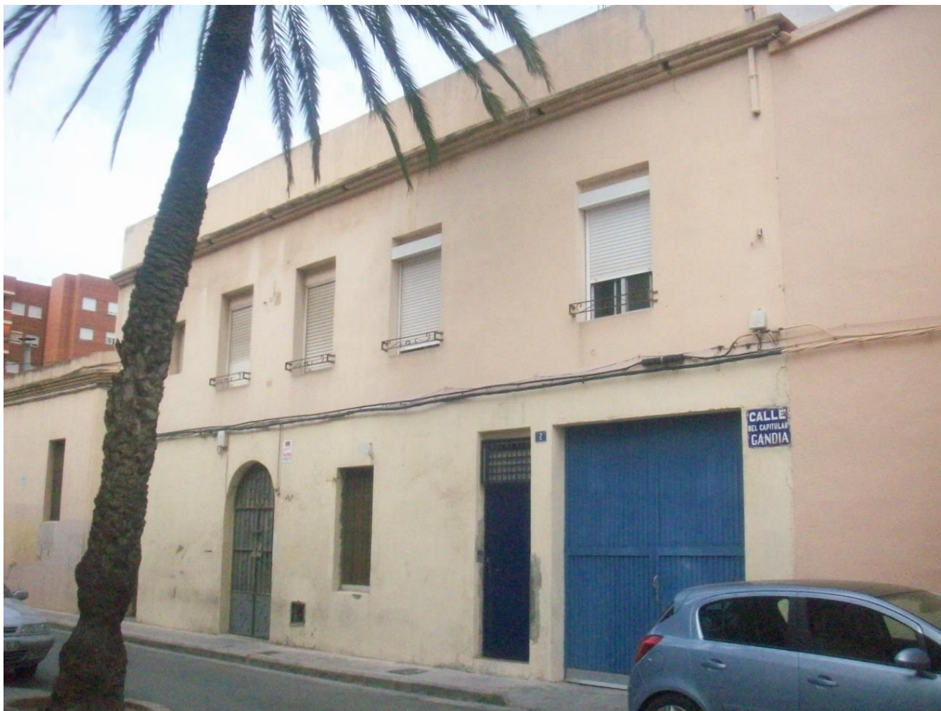
Foto 32. Fachada este. C/Capitular de Gandia
