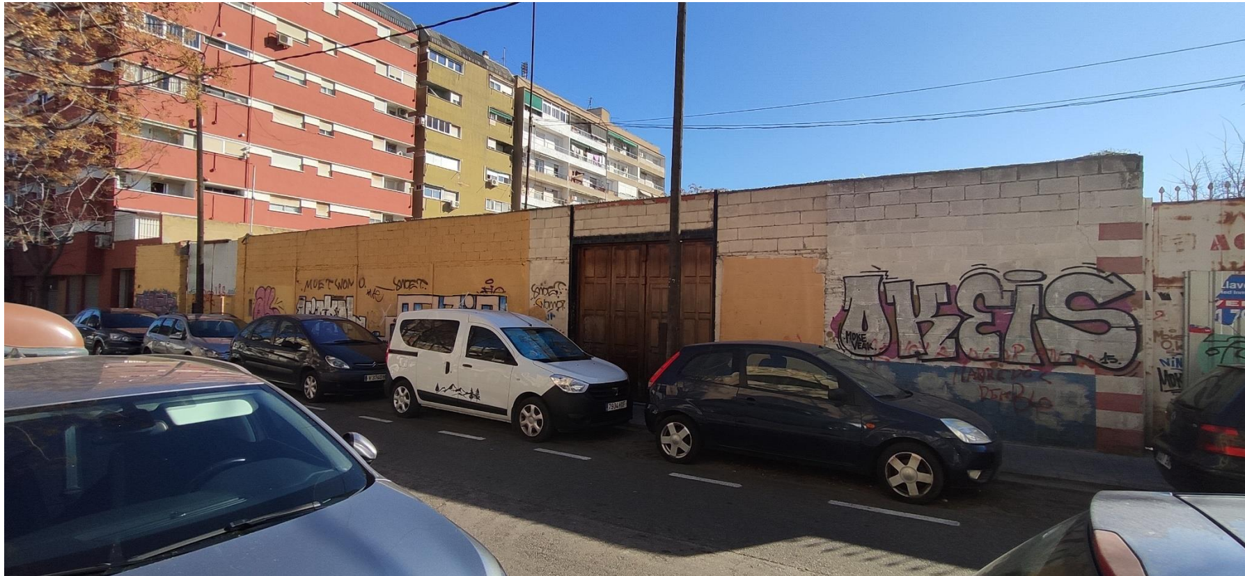
Foto 36. Fachada norte completa. Carrer Mossen Febrer
