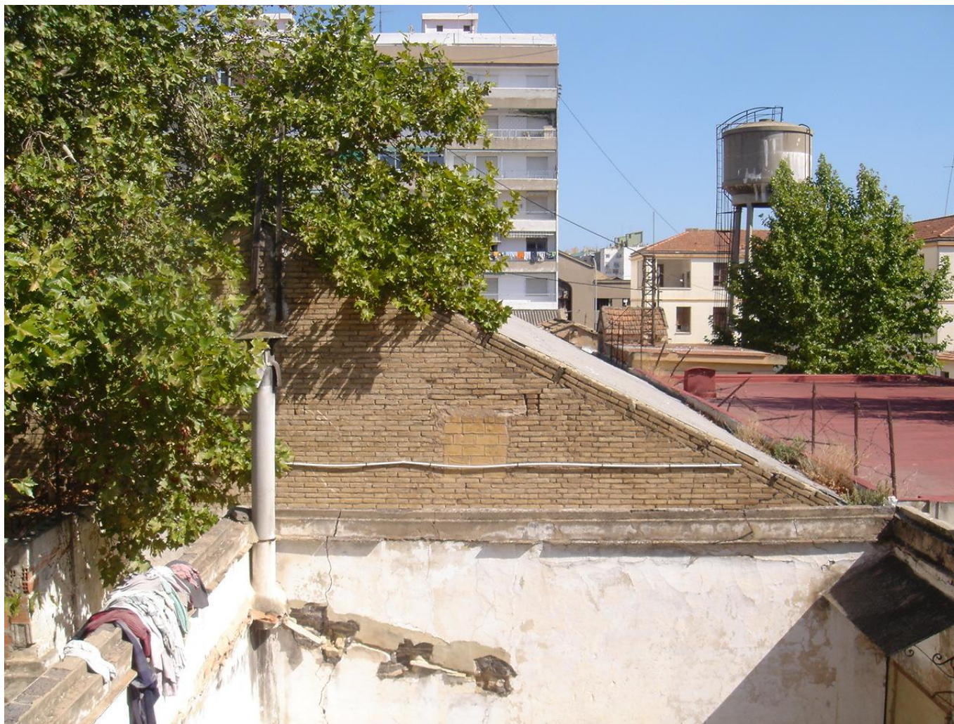
Foto 19. Fachada oeste y medianera sur
