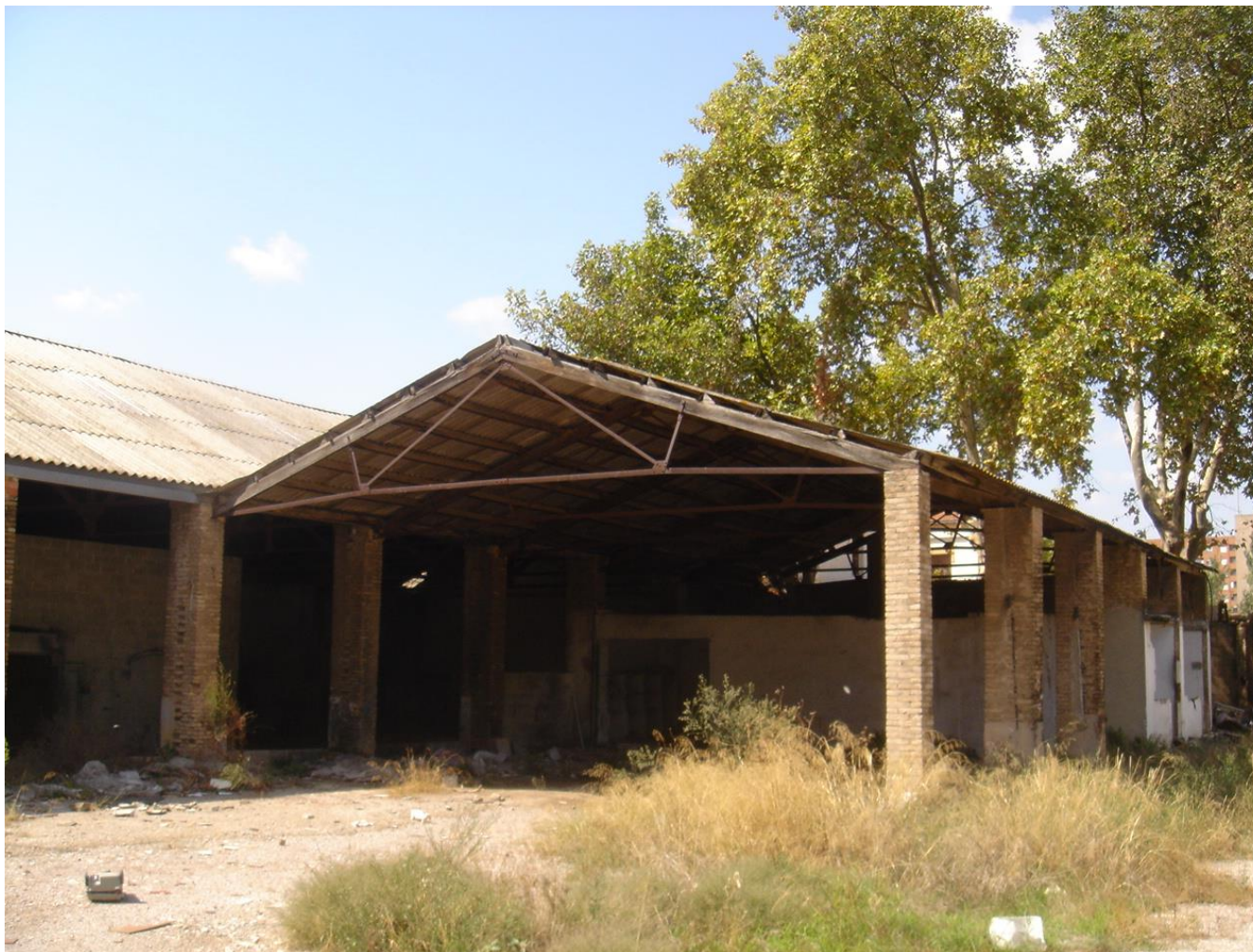
Foto 16. Fachadas norte y este
