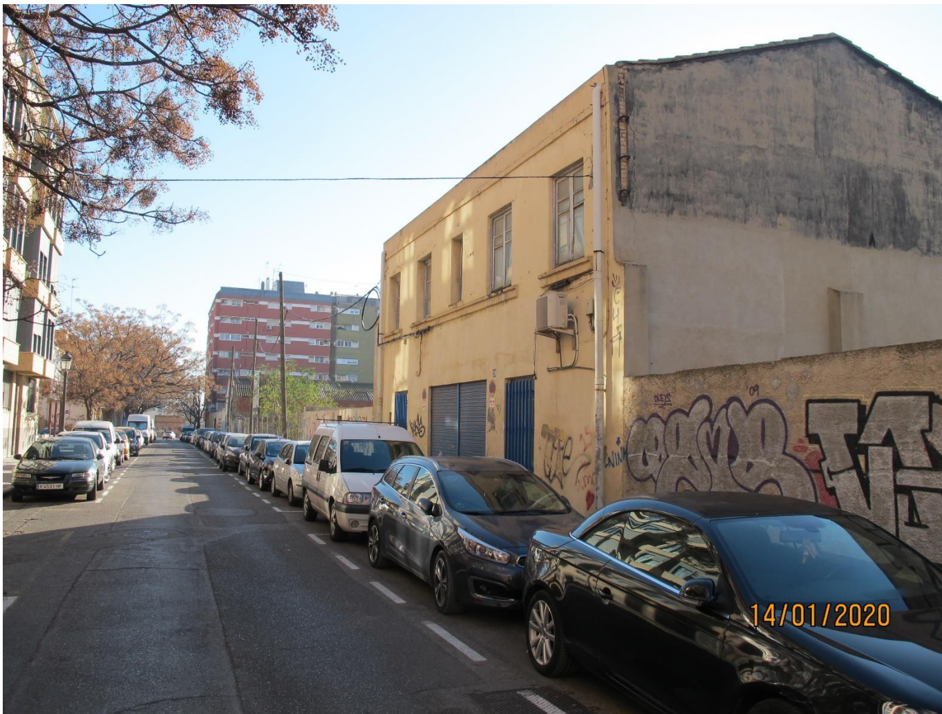
Foto 9. Fachada norte. C/Mosen Febrer
