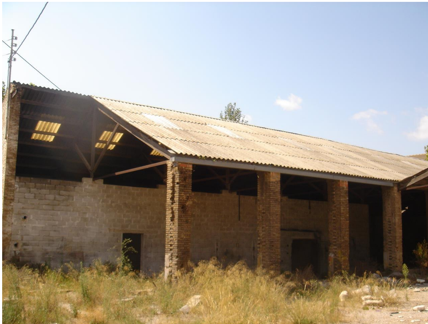
Foto 17. Fachadas norte y este
