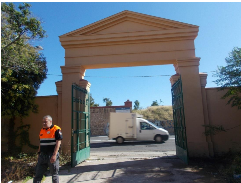
Foto 11. Antiguo acceso principal del Cuartel de Artillería.
