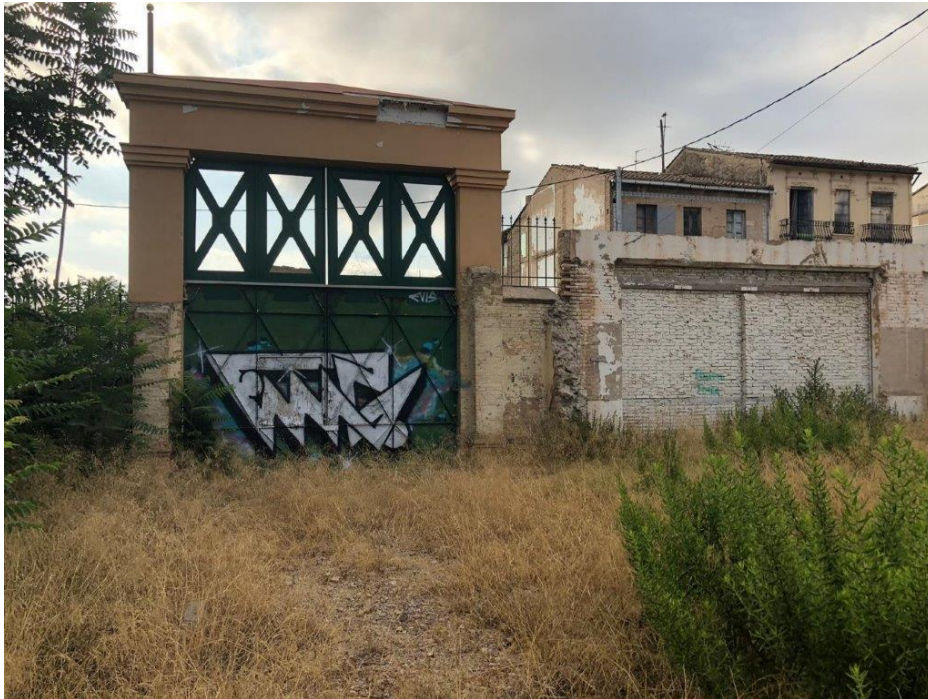
Foto 13. Puerta secundaria del muro.
