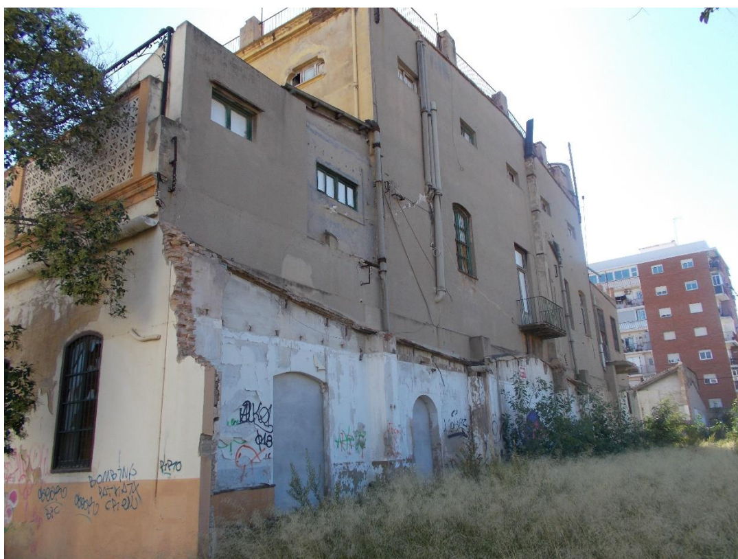
Foto 8. Vista oeste parte trasera del edificio
