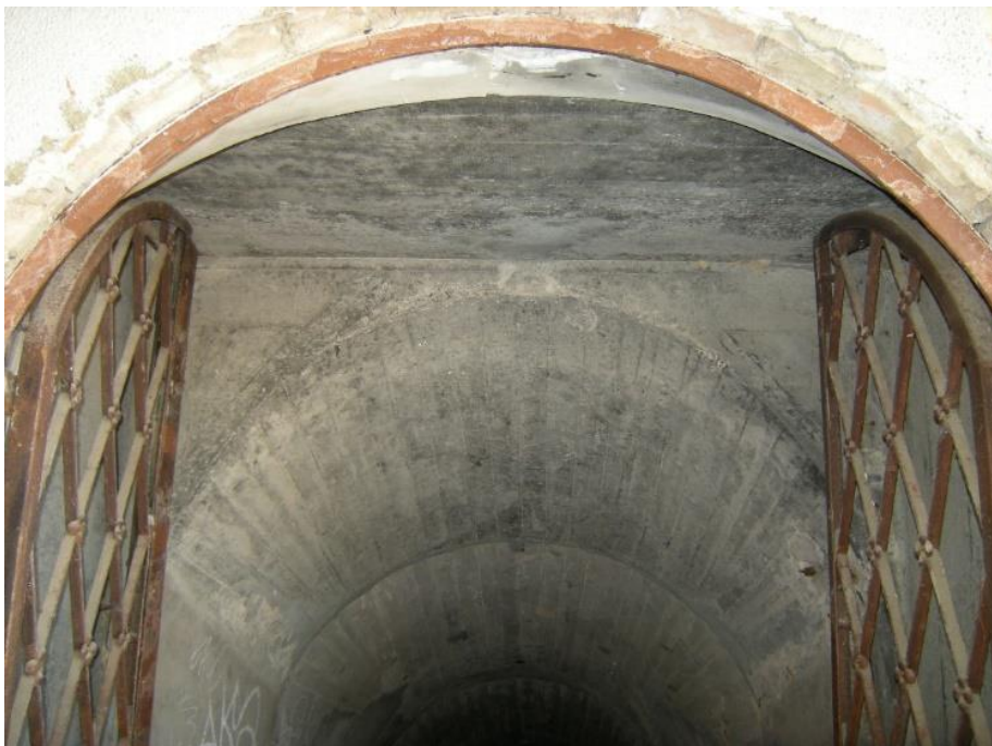
Foto 14. Puerta de acceso al refugio antiaéreo.
