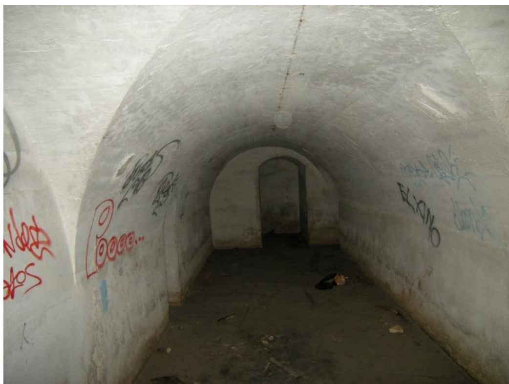
Foto 16. Vista del nivel inferior del refugio antiaéreo.
