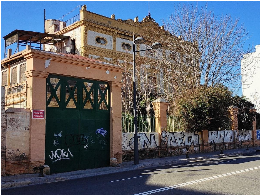
Foto 6. Entrada lateral y fachada edificio
