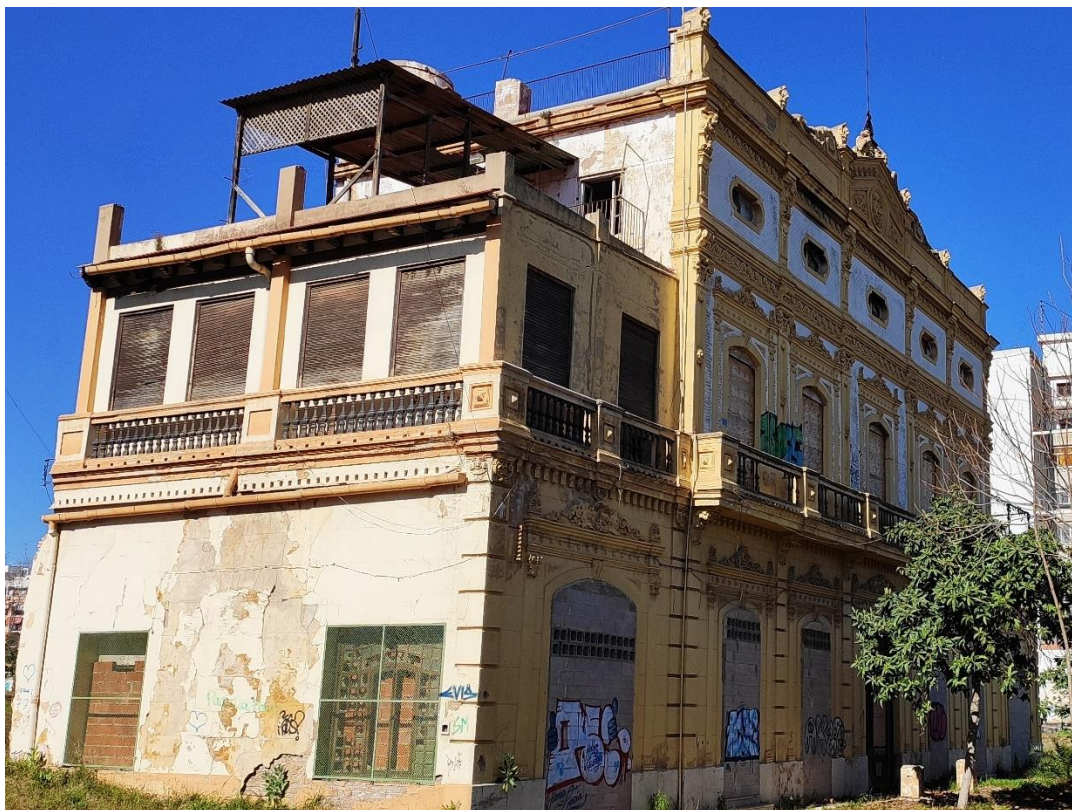
Foto 7. Vista sur del edificio
