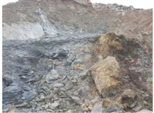
Imagen nº 20: Detalle del de la zona de fractura.
