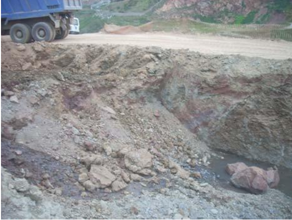
Imagen nº 19: Detalle de la zona de fractura asociada al borde occidental del nivel de conglomerados. Obsérvese la presencia de arcillas rojas asociadas al contacto.
