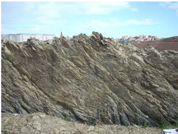
Imagen nº 11: Aspecto general de una zona de fractura en esquistos.
