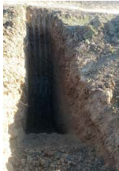
Ilustración 14: Relleno nivel producido por la remoción de las arcillas
