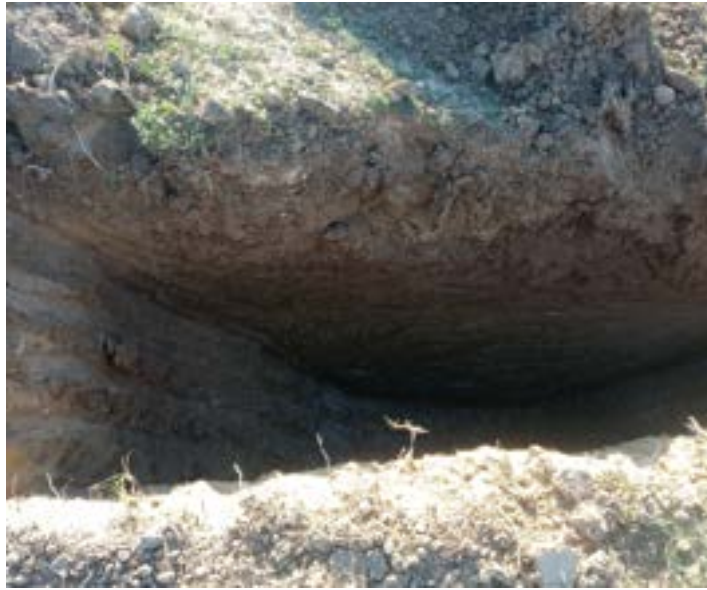
Ilustración 13: Aparición de arcillas a escasos centímetros del nivel antrópico
