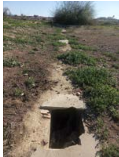
Ilustración 6: Imagen en la que se aprecia el tratamiento de hormigón para la ejecución de la canalización.
