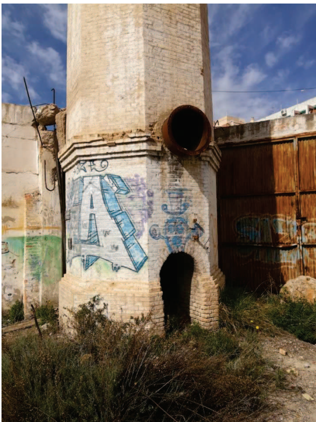
Relación del conducto de derivación de humos con la chimenea
