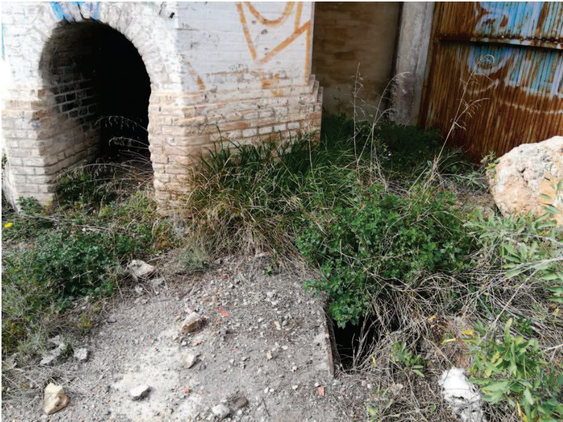
Relación del conducto de derivación de humos con la chimenea
