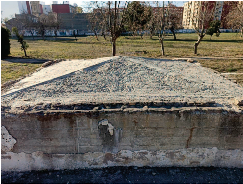
Detalle del remate a cuatro aguas
