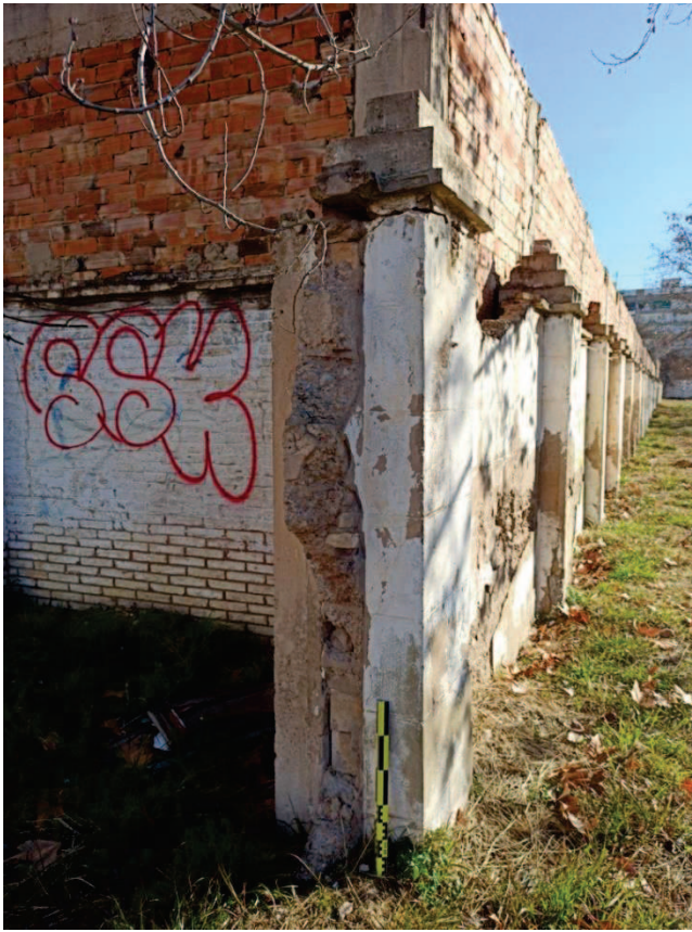
Detalle del corte de la tapia original
