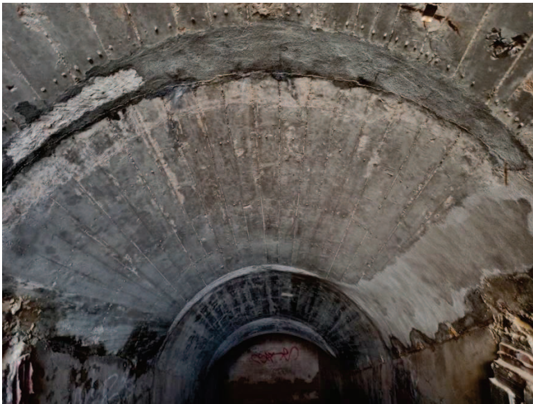
Detalles de la escalera y bóveda
