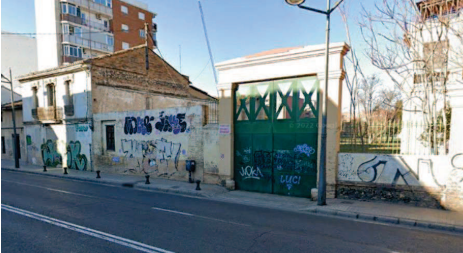
Puerta secundaria de acceso al recinto
