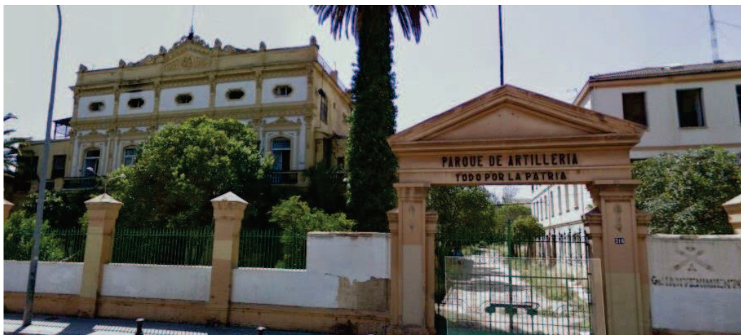
Vista de la puerta y verja principal antes del derribo de las naves del cuartel
