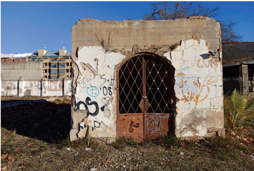
Puerta de acceso al refugio
