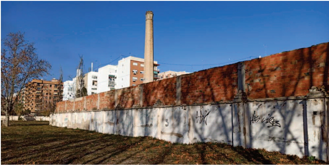
Vista general del subtramo
