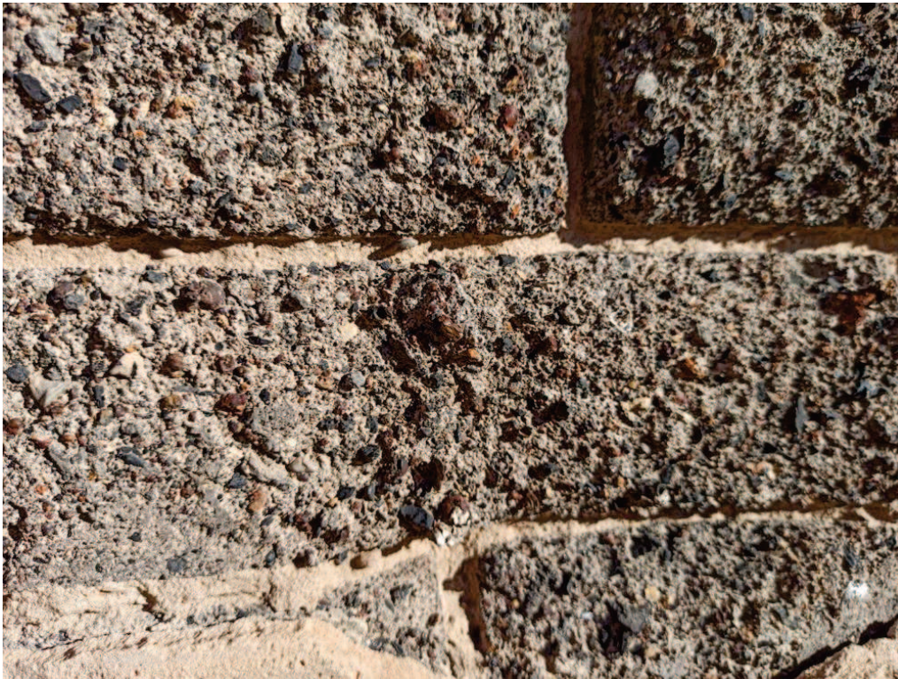
Detalle de la composición de bloques con partículas de ganga de metal y de carbón de coque
