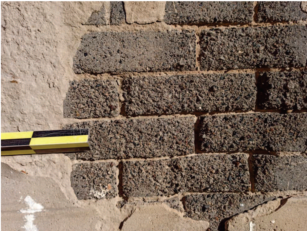
Detalles de los bloques o ladrillos de ganga de metal y carbón de coque
