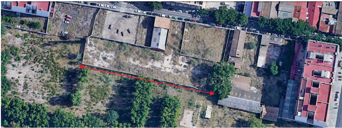
Situación del tramo de tapia a las espaldas del refugio
