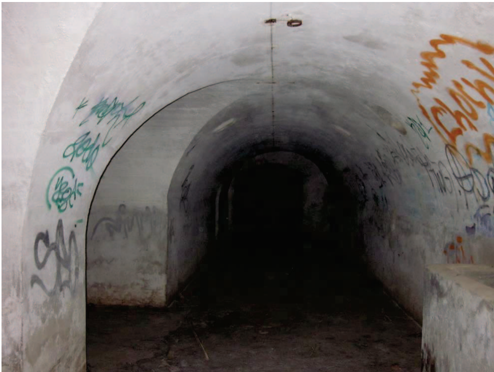
Nave central con pileta a la derecha de la imagen y huellas del cableado eléctrico
