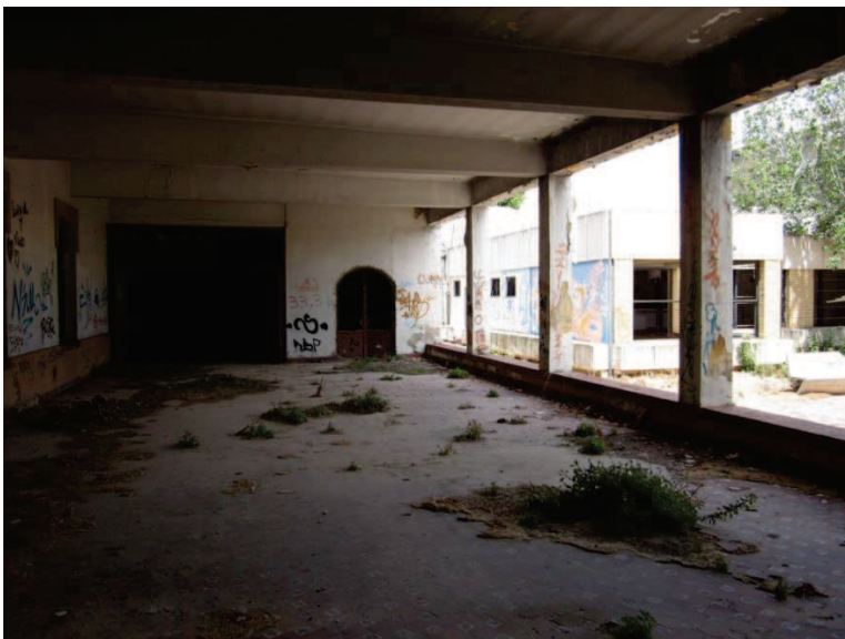
Situación del acceso en el edificio
