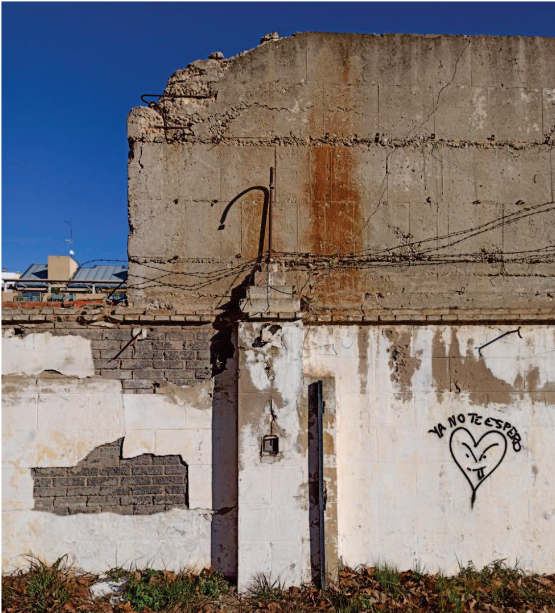
Detalle de un pilar y detrás refuerzo de encofrado de hormigón. Sobre el pináculo se encuentra el brazo de una farola
