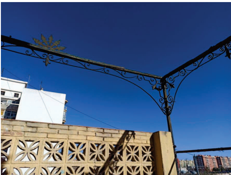
Rejería original de la pérgola del al terraza norte
