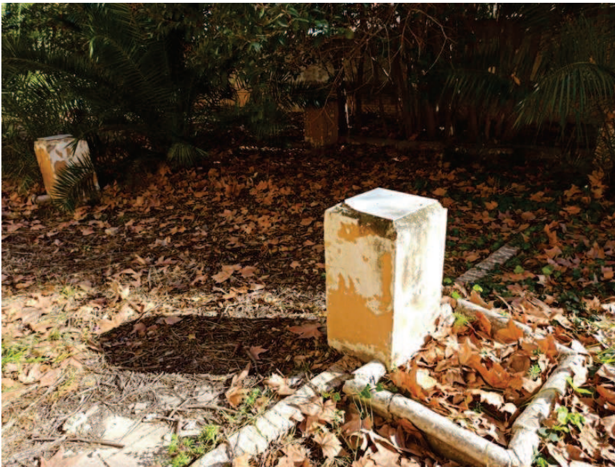
Detalles de los pilones de una posible pérgola
